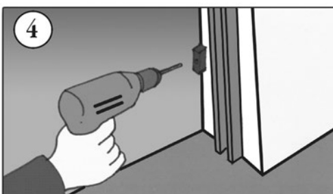
Posizionare le guide nella sede e fissarle
